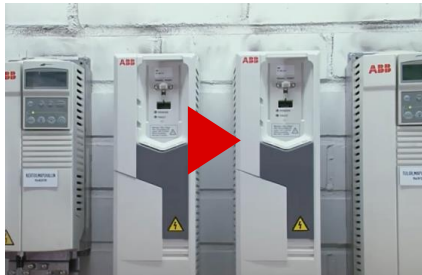
Installation de l'ACS580
